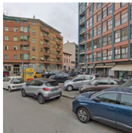
Milano | Urbanistica – Al via la depavimentazione per circa 6.000 metri quadri
