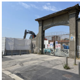
Milano | Calvaire – Demolizioni del vecchio mercato avicunicolo di via Vismara e Lombroso
